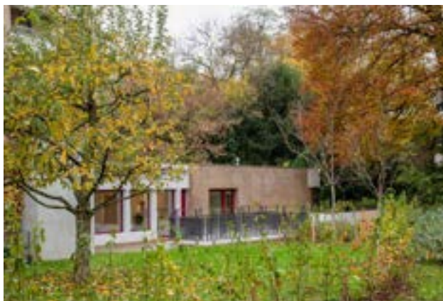
Die neu eröffnete Kita im Dalbehof von aussen...
